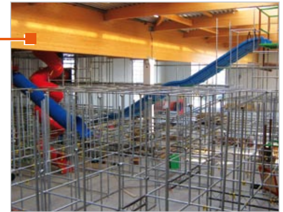
... über das dreistöckige Gerüst ...
