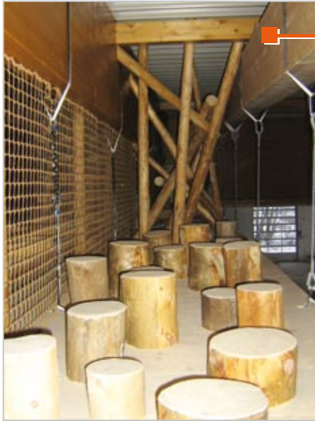
Direkt unter dem Dach wird ein Natur-Klettergarten installiert.
