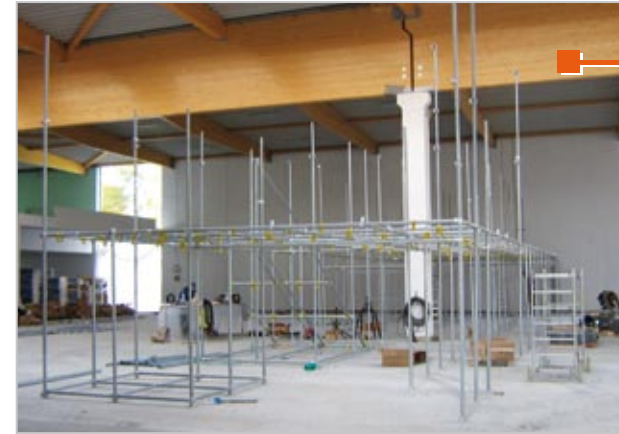
Die Entstehung des Kinderspielturms: von ersten Stahlelementen ...
